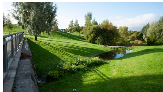
Nedsänkt yta som kan rymma skyfallsvatten vid en extremhändelse.
